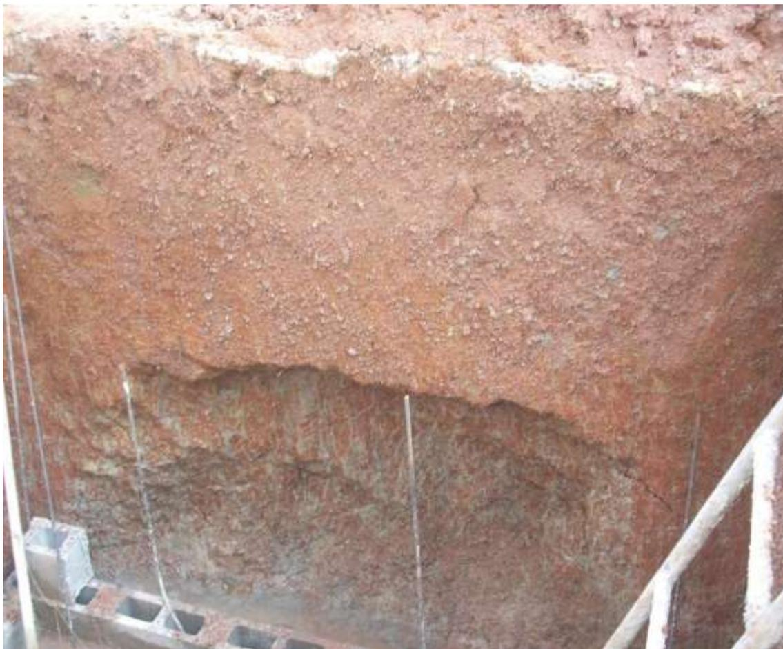
Figura 10. Vista del afloramiento AF34, en el cual se aprecia una dolina rellena de arcillas de descalcificación con cantos de caliza de diverso tamaño.
