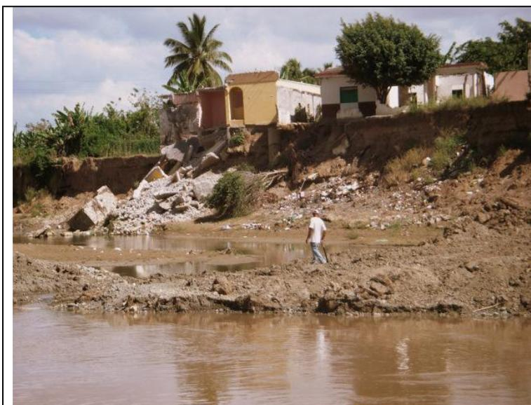
Fig. 80: Riesgos de deslizamientos Vista de los deslizamientos ocurridos en Sabaneta en la orilla del Río Camu
