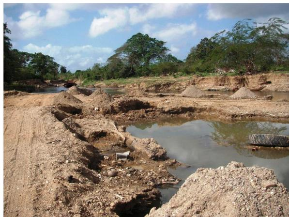
Fig. 89: Recursos no metálicos: Explotación de los niveles arenosos en el cauce del Río Jaya
