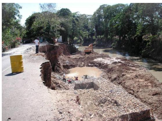
Fig. 82: Riesgos de deslizamientos Carretera deslizada en la orilla del Río Camu en la Tala durante la tormenta Olga
