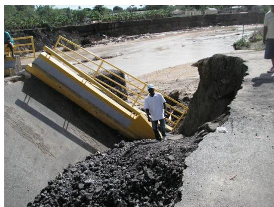
Fig. 83: Riesgos de deslizamientos Puente destruido con un deslizamiento de la ribera derecha del Río Licey.
