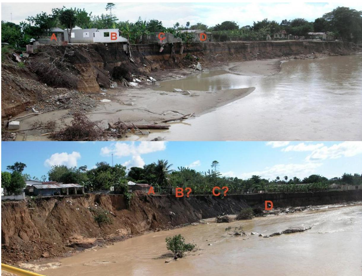
Fig. 84: Riesgos de deslizamientos – Vista de la evolución de los daños ocurridos en la orilla derecha del Río Licey en la Guama de Guanábao entre la Tormenta Noel en Octubre 2007 y la tormenta Olga en Diciembre 2007
