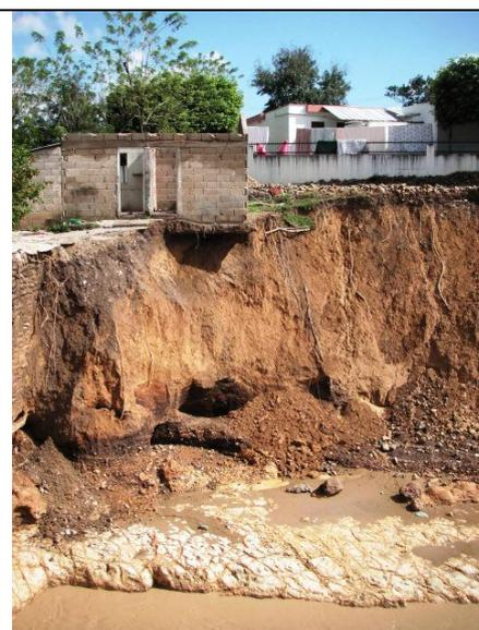
Fig. 79: Riesgos de deslizamientos Vista de la evolución de los daños ocurridos en la orilla derecha del Río Licey en la Guama de Guanábao entre la Tormenta Noel en Octubre 2007 y la tormenta Olga en Diciembre 2007
