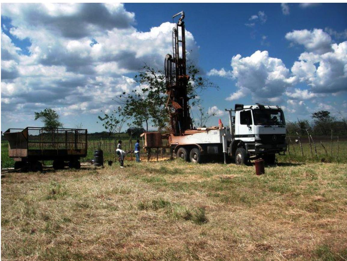
Fig. 75: Descripción hidrogeológica – Sondeo hidrogeológico en los conglomerados de Azlor infrayaciendo el glacis pastoso.
