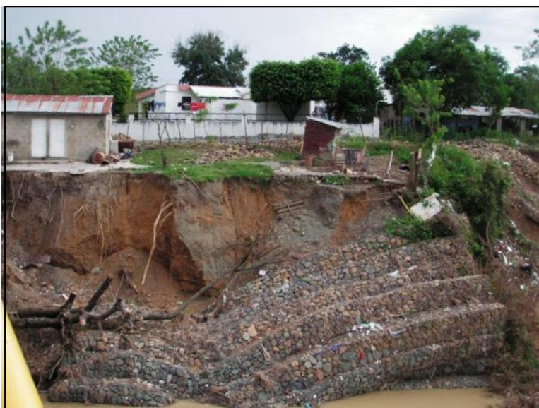
Fig. 78: Riesgos de deslizamientos – Vista del comportamiento de los gaviones en los deslizamientos
