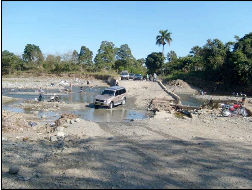
Foto 54.- Efectos de la avenida Olga (2007) sobre un puente del Río Camú en La Vega.
