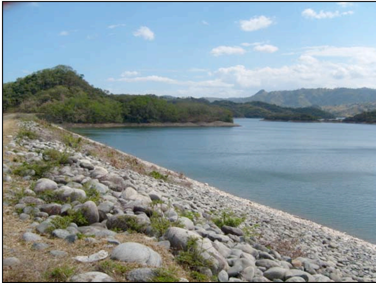
Foto 22.- Presa de tierra del Embalse de Bao.
