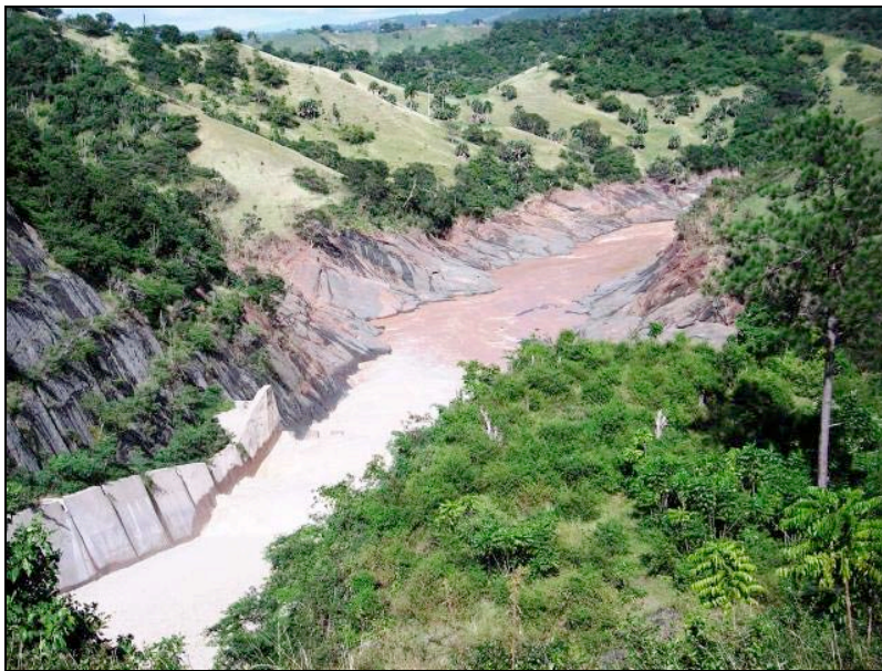
Foto 55.- Vista del canal de desagüe de la presa de Tavera después de la Tormenta Olga (2007), donde se observa el nivel que alcanzaron las aguas río abajo.
