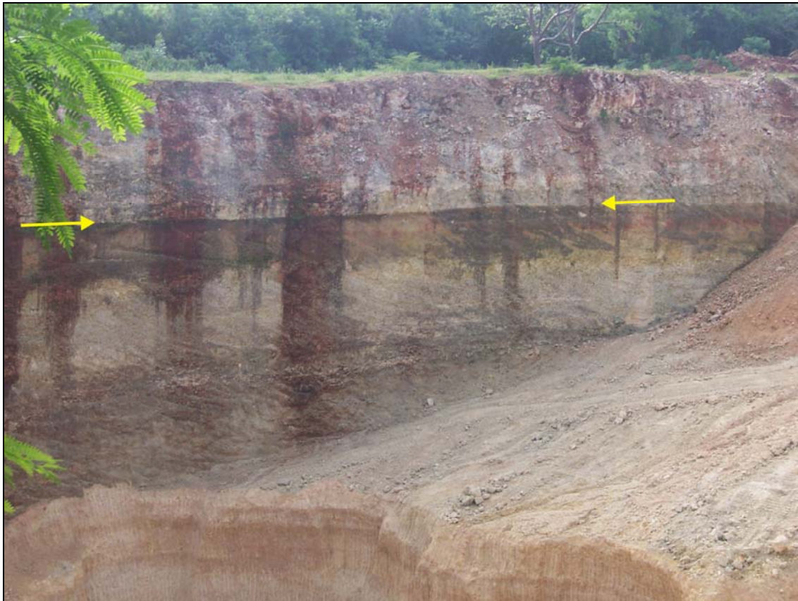
Foto. 4.1. Sección de la Fm La Isabela en la cantera de La Atravesada, llamando la atención la superficie neta, correspondiente a una superficie erosiva con arcillas rojas
