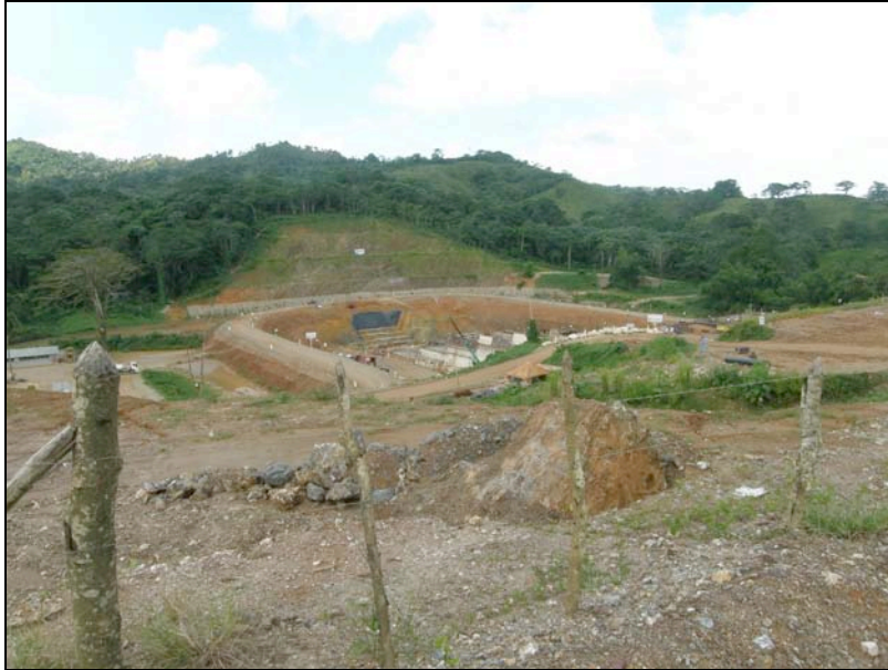
Foto 26.- Vista de la Presa del Río San Juan, en construcción (2008).
