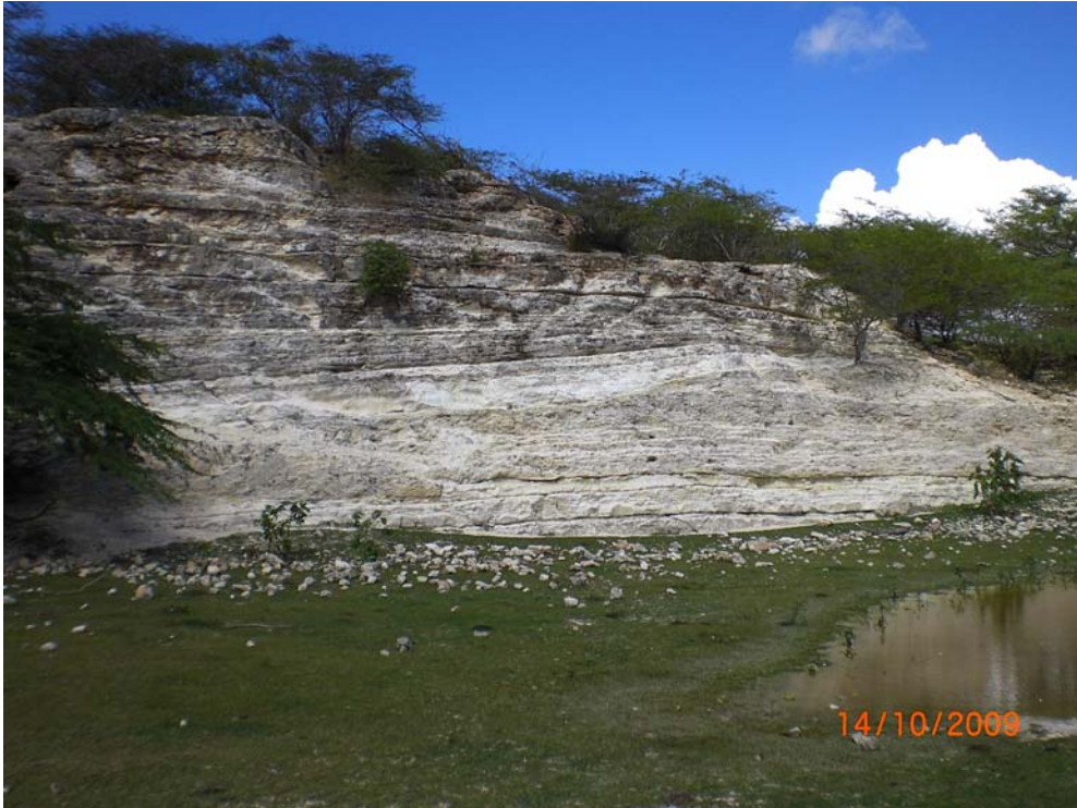
Foto 1.- Explotación de caliza abandonada
