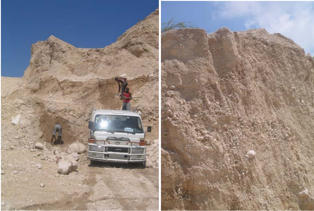
Foto 43. Indicio nº 4. Arranque ocasional de gravas con medios manuales.
