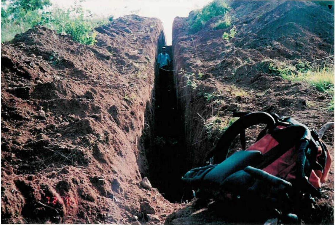
Vistas trinchera Trinidad
