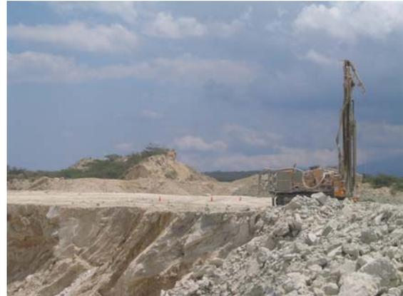
Foto 4. Preparación de la pega. Arranque con explosivos
