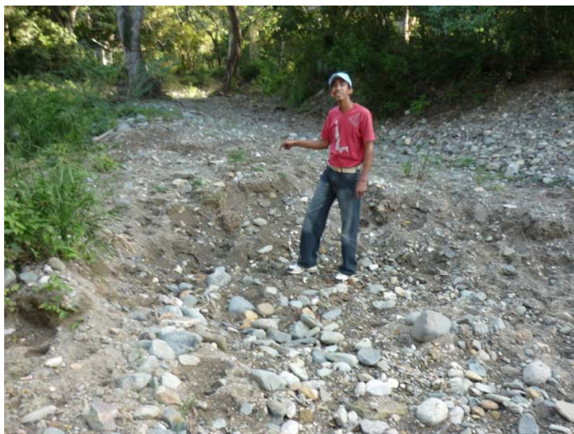
Foto 9. Restos de lavado en el cauce del Arroyo Sui
