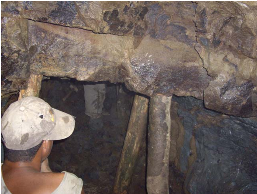
Foto 7. Minero trabajando en el interior de una galería, con rudimentarios entibados de madera. (indicio 60741007 – Palo Quemado)
